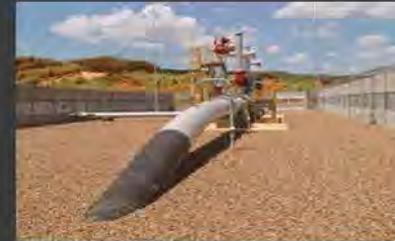
**POLIDUCTOS:** SON REDES DE TUBERÍAS DESTINADOS AL TRANSPORTE DE HIDROCARBUROS O PRODUCTOS TERMINADOS.
