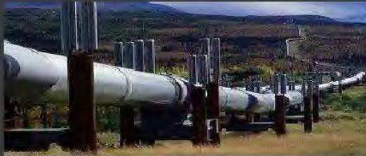
**GASODUCTOS:** CONDUCE EL GAS NATURAL QUE PUEDE PRODUCIRSE DESDE UN YACIMIENTO DE GAS LIBRE O ASOCIADO A PLANTAS SEPARADORAS Y FRACCIONADORAS. A PARTIR DE DICHS PROCESOS DE SEPARACIÓN, EL GAS YA TRATADO ENTRA A LOS SISTEMAS DE TRANSMISIÓN PARA SER DESPACHADO AL CONSUMIDOR INDUSTRIAL Y DOMESTICO.
